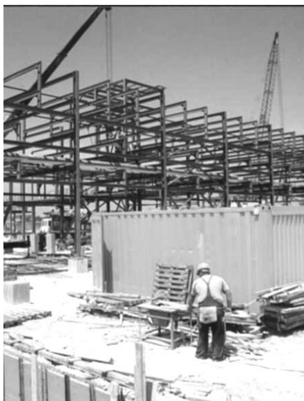
Un cantiere edile
